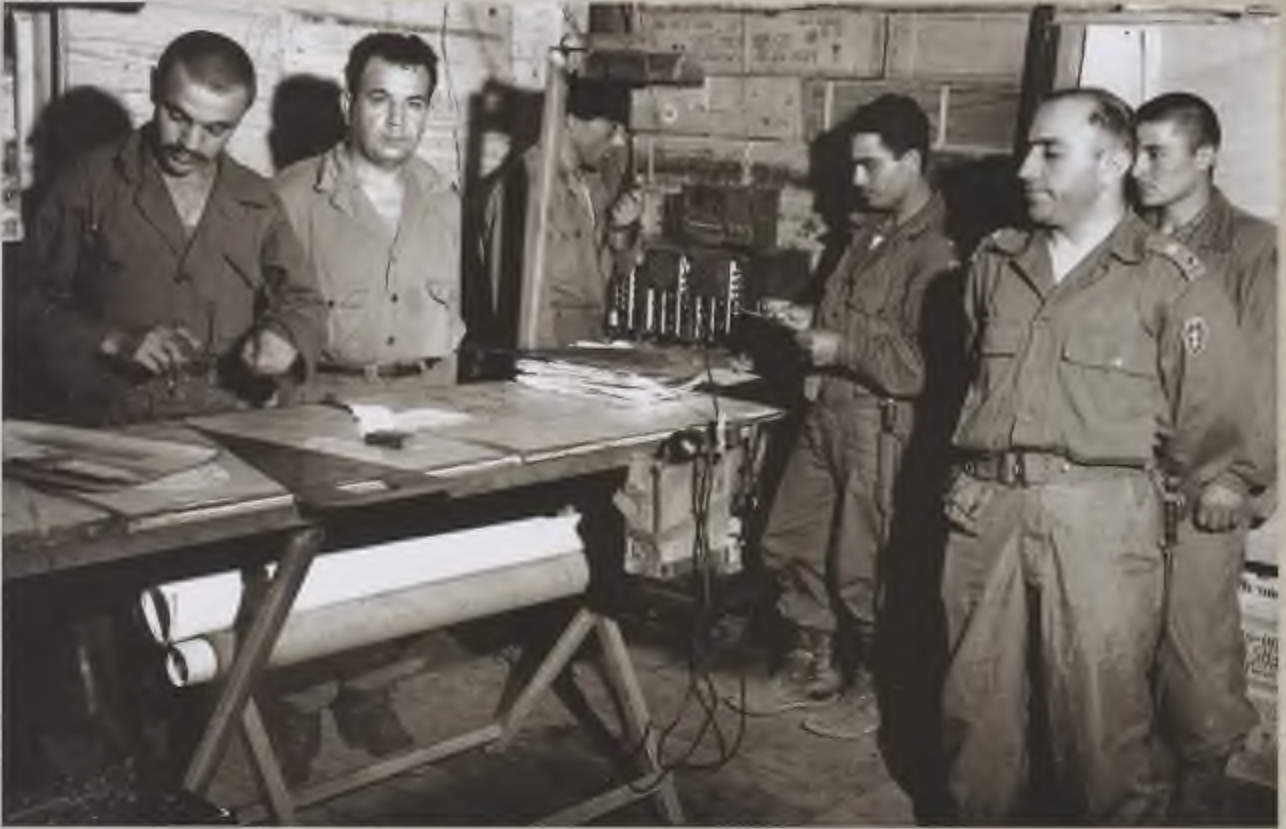
Ateş idare merkezinde çalışan subaylarımız. Our officers at the fire control center.
