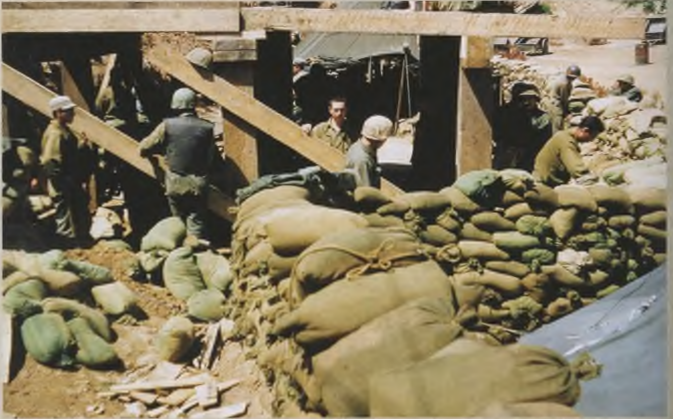
Hattlarımızda onarım yapan ve korugan inşa eden İstihkâmcılarımız. Our engineering units repairing the lines and building blockhouses.
